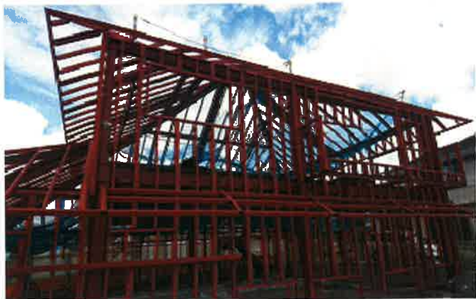
Mグレード指定であったが施工者がなくR指定を認めていただいた物件
