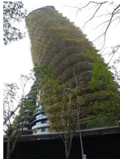
工事中的の写真 (2017年3月)
