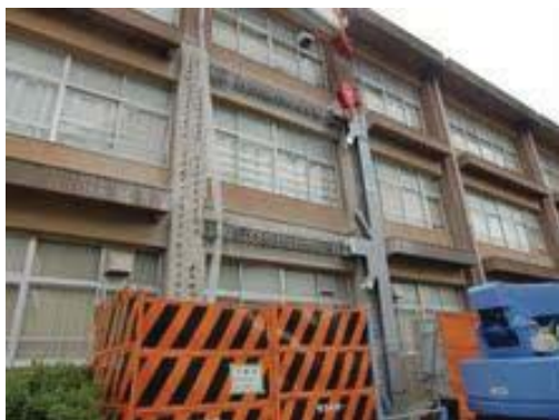
特別教室棟 鉄骨ブレース取り付け
