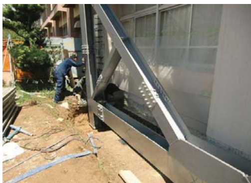
普通教室棟 鉄骨ブレース取り付け
