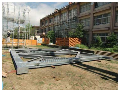
普通教室棟 鉄骨ブレース地組
