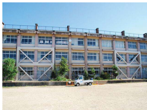
普通教室棟 完成
