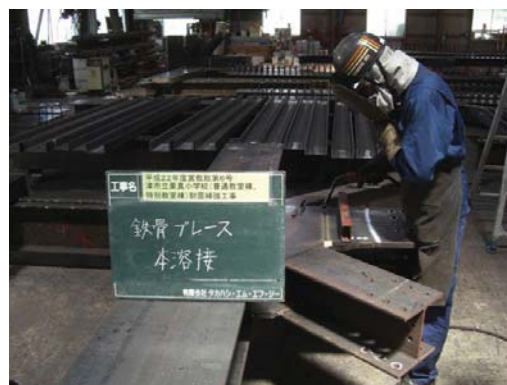
鉄骨ブレース 本溶接
