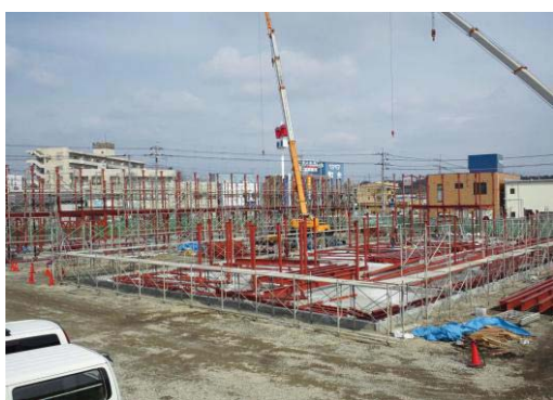
甲府駅北口デッキ大屋根鉄骨工事
