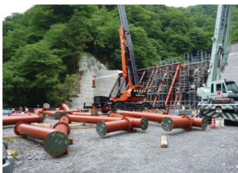
砂防ダム鋼製スリット
