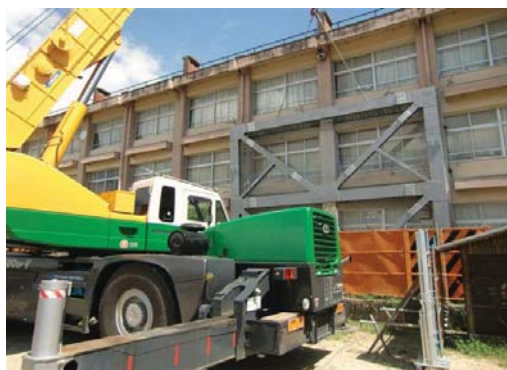
普通教室棟 鉄骨ブレース取り付け
