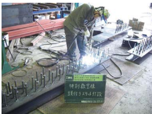
スタッドジベル打設状況
