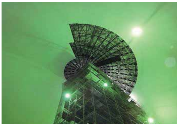
■プラネタリウム骨組の設置作業(1)
