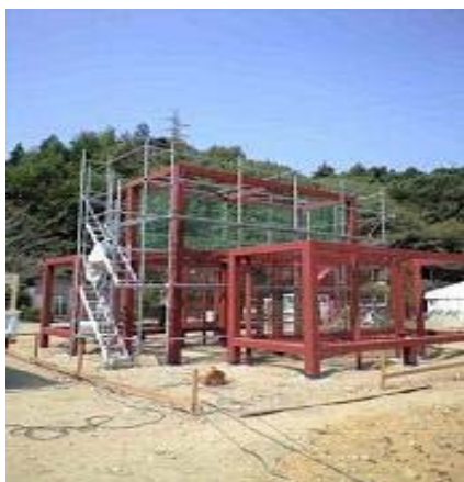
施工中の写真
