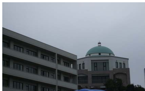
写真は施工例 (ドーム部分)
